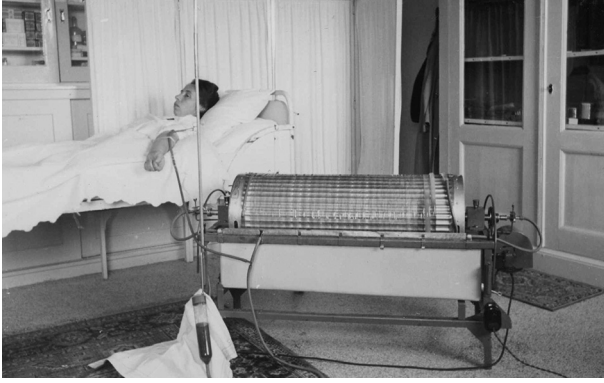
FIGUUR 2 De eerste kunstnier (Kampen, eind 1942). 2,6 Een slang van cellofaan ('worstenvellen') is spiraalsgewijs 30 maal rond een cilinder van gegalfd aluminium gewonden; de slangen die met het bloedvat (vene of arterie) van de patiënt verbonden zijn, bevinden zich in de holle as (een waterdichte constructie afkomstig uit het koelingsstelsel van een T-Ford). 7 Het onderste deel van de cilinder rust in het bad met spoelvlloeistof. De cilinder wordt rondgedraaid door een op de grond geplaatste elektromotor, door tandwielen en ketting verbonden met de as. Alle slangen werden voor gebruik gesteriliseerd. Voor de foto heeft de hoofdzuster (Maria ter Welle) de plaats van de patiënt ingenomen.
